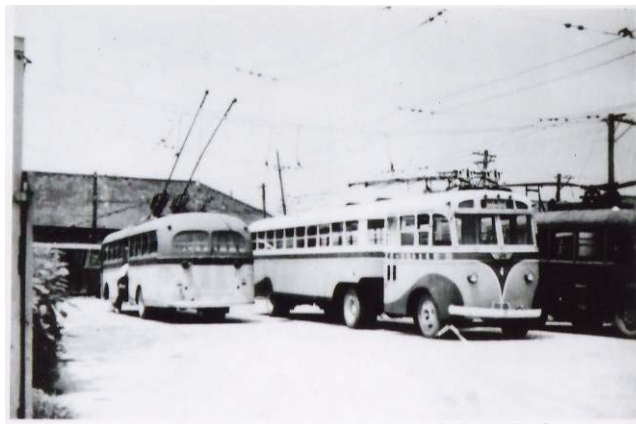
写真 8 2号車と1号車 御器所車庫
